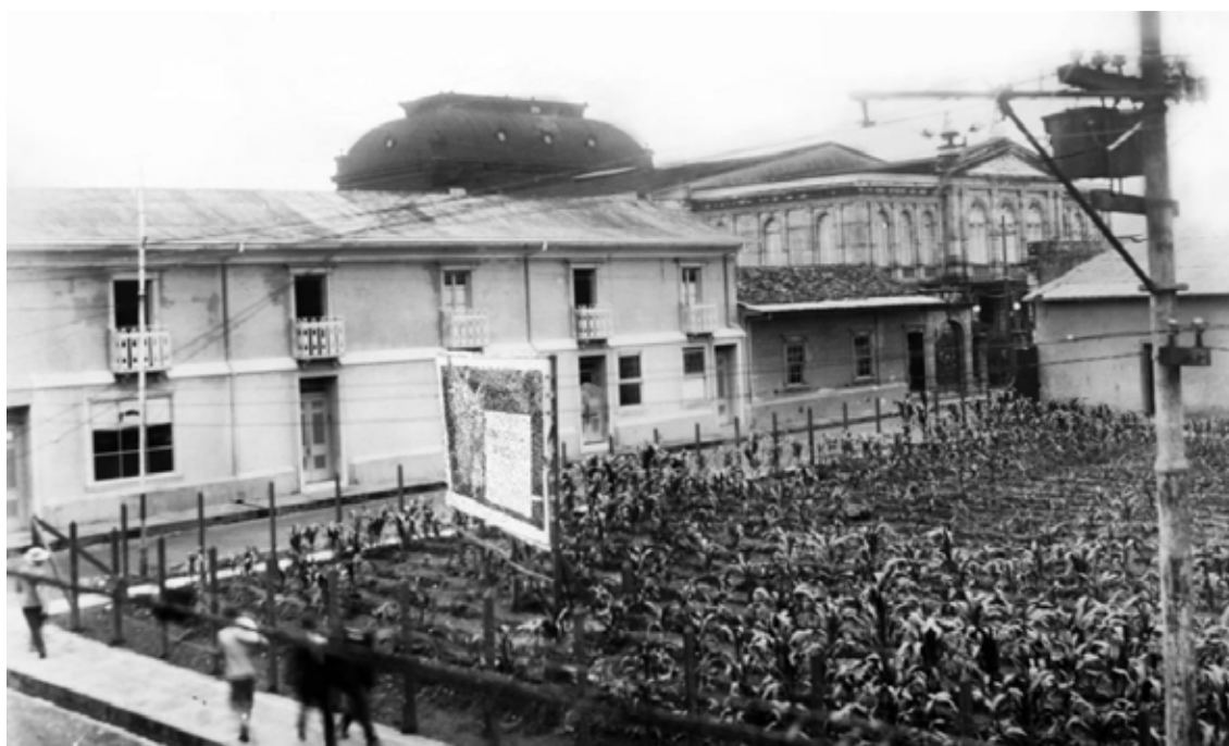
Fotografía 7: Lote anterior a la construcción del Hotel Costa Rica (sin fecha)
