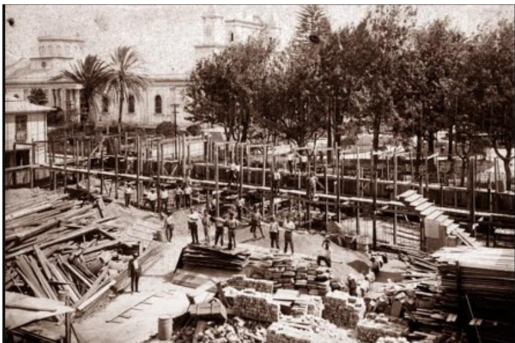
Fotografía 8: construcción del Teatro Raventós (actual Teatro Melico Salazar / sin fecha)
